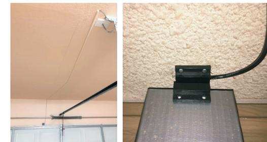
В закрытом состоянии расстояние между подвижной и неподвижной частями датчика открытия/закрытия должно быть 3-15 мм.
